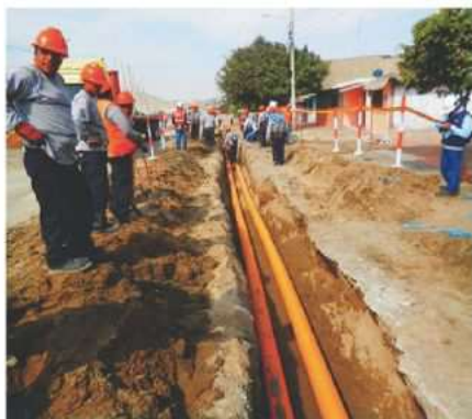
Colocación de tuberías
