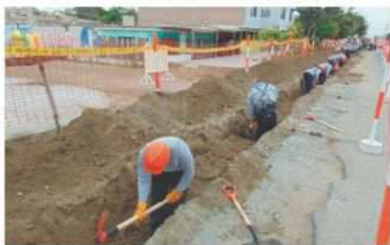
Excavación manual
